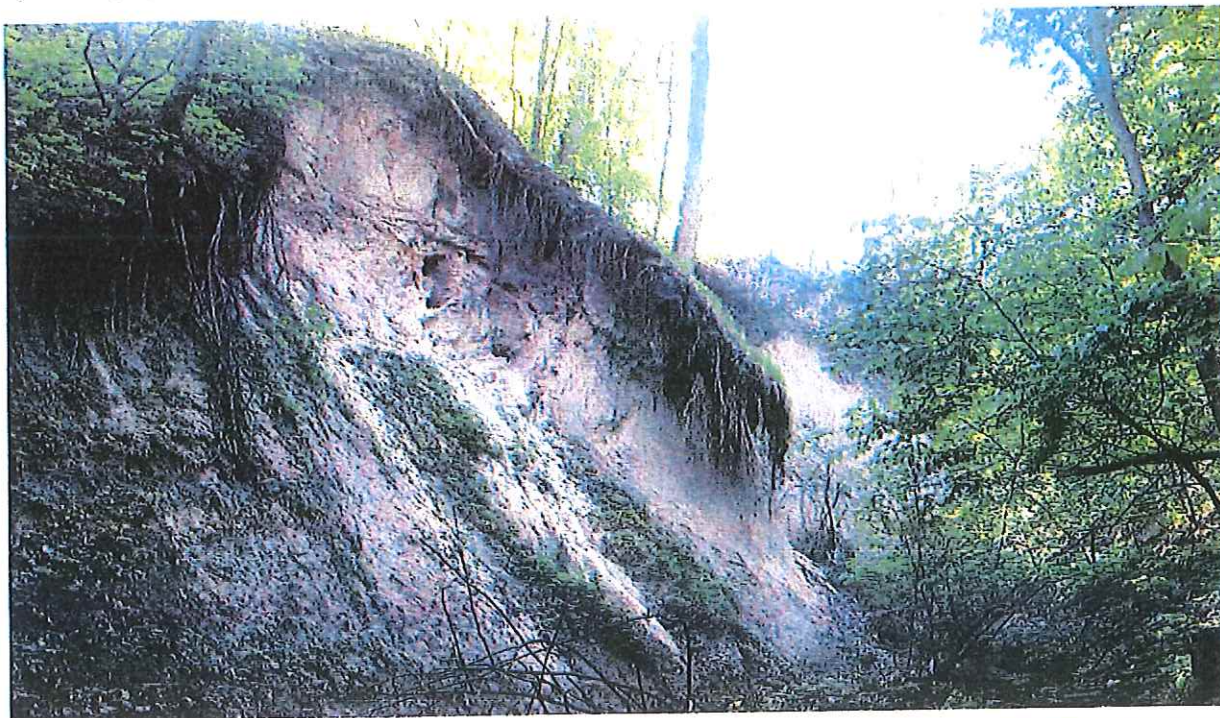
Zdj. 3. Skarpa główna w północnej części osuwiska
