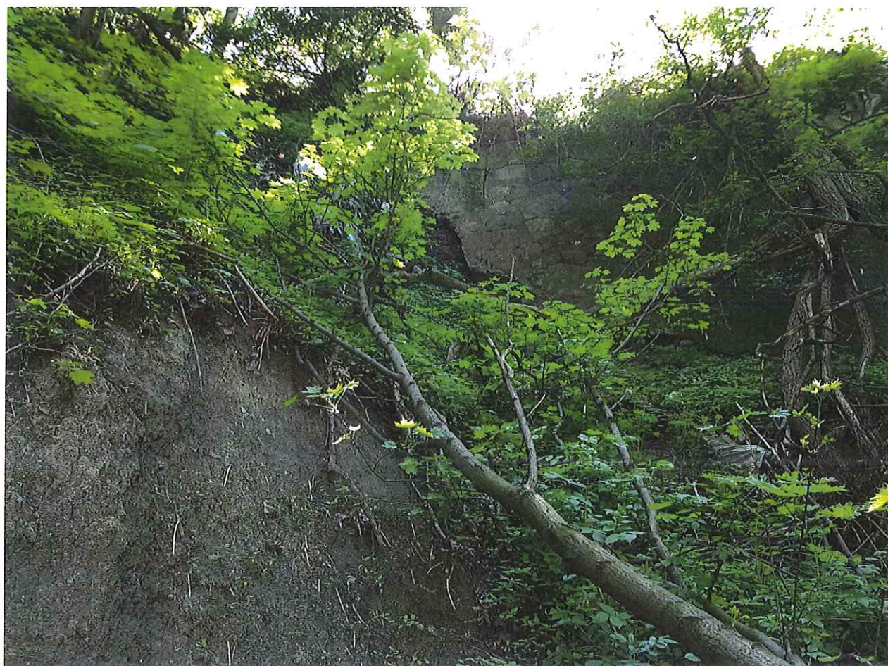
Fot. 8. Mur oporowy w górnej krawędzi jaru (od strony wschodniej)
