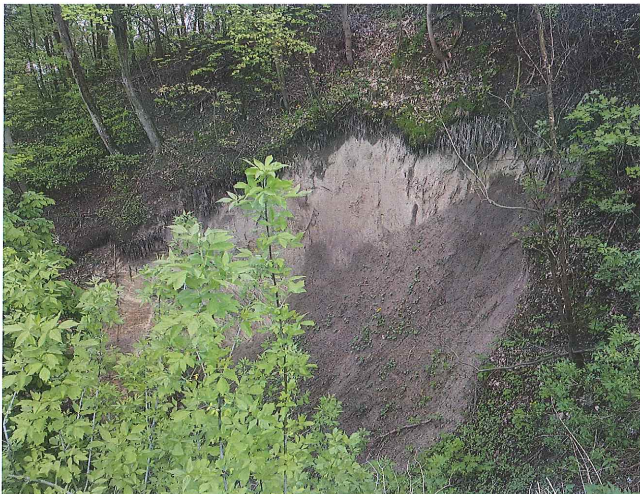
Fot. 2. Osuwisko od strony południowej za murem oporowym (zał. nr 11 zdjęcie 2)
