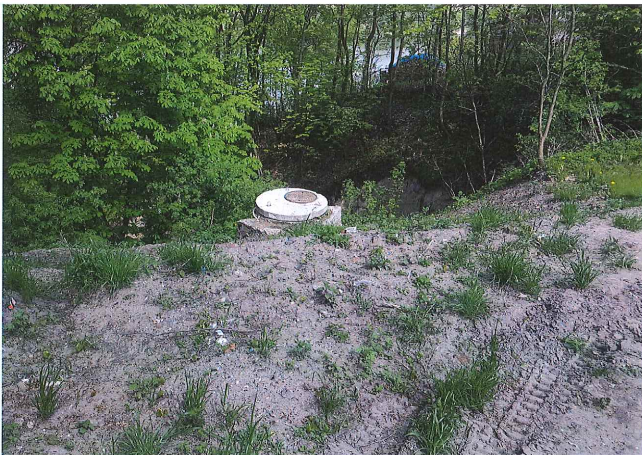
Fot. 1. Studnia kanalizacji deszczowej przed murem oporowym
