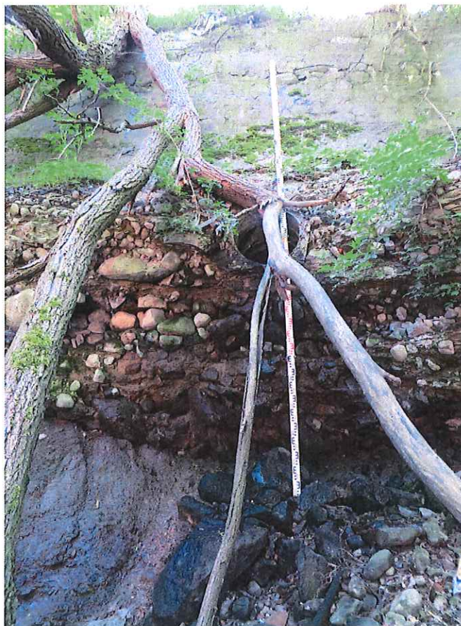
Fot. 9. Wylot kanalizacji DN600 przy fundamencie muru oporowego
