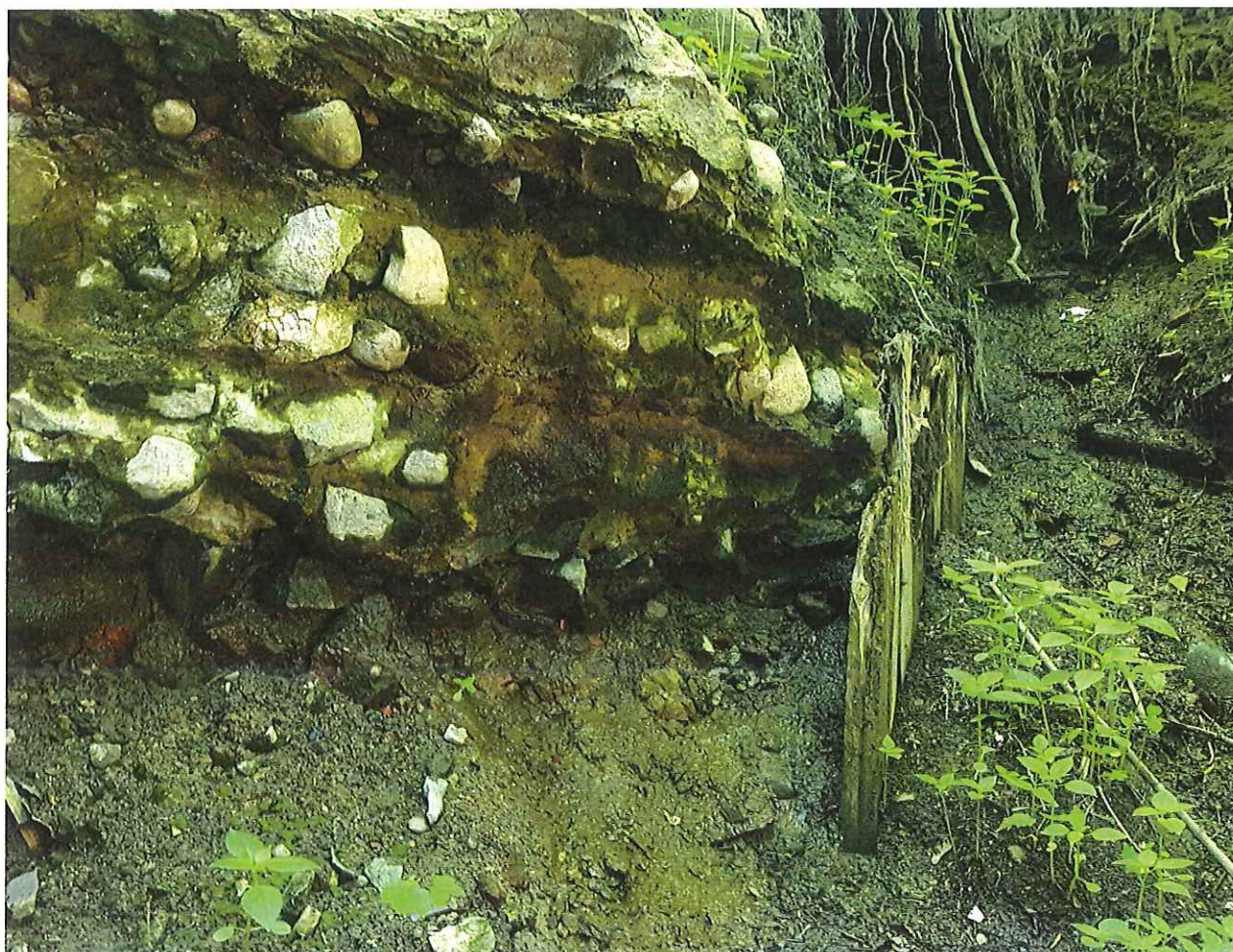
Fot. 10. Fundament kamienny muru oporowego od strony zachodniej jaru
