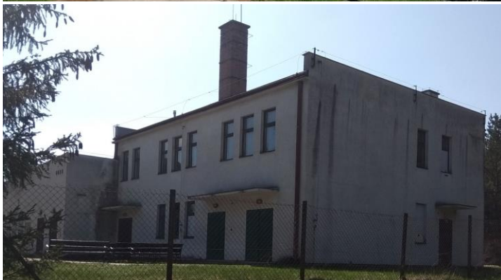
- 45 – Budynek Szkoły Zaborowo – (w budynku znajduje się 1 lokal mieszkalny własnościowy)
