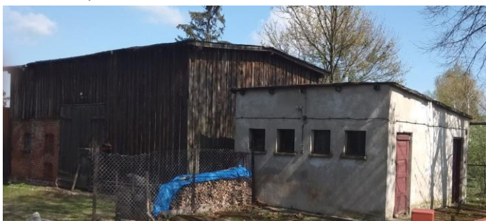
- 48 – Budynek drwalnia – Zaborowo
