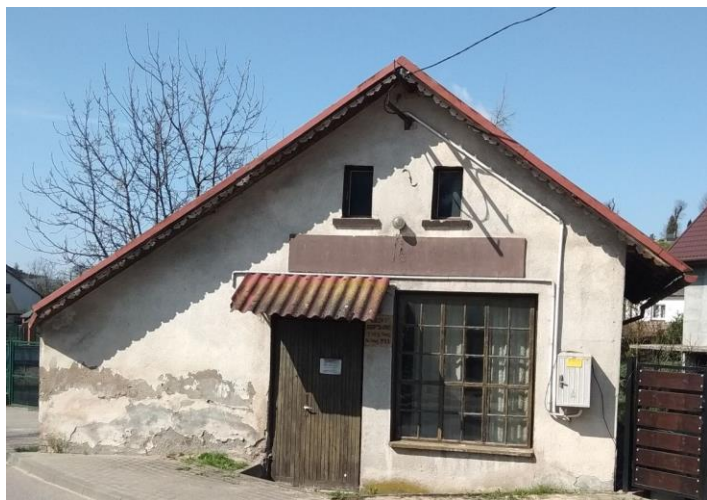
- 19 – Budynek Szkoła Fiałki
